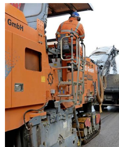
Bauverzögerungen können zu Streit mit Bieter führen. FOTO: DPA
